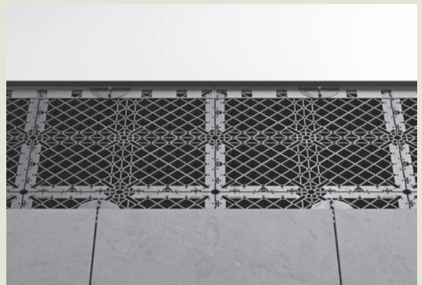
Positionnement du profilé avec GRF System Positionierung des Randprofils auf dem Gitter
