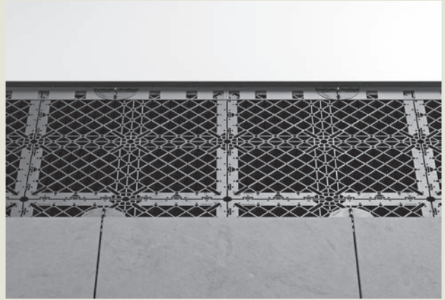
Postavljanje profila na nosače Postavitev profila na nosilce
