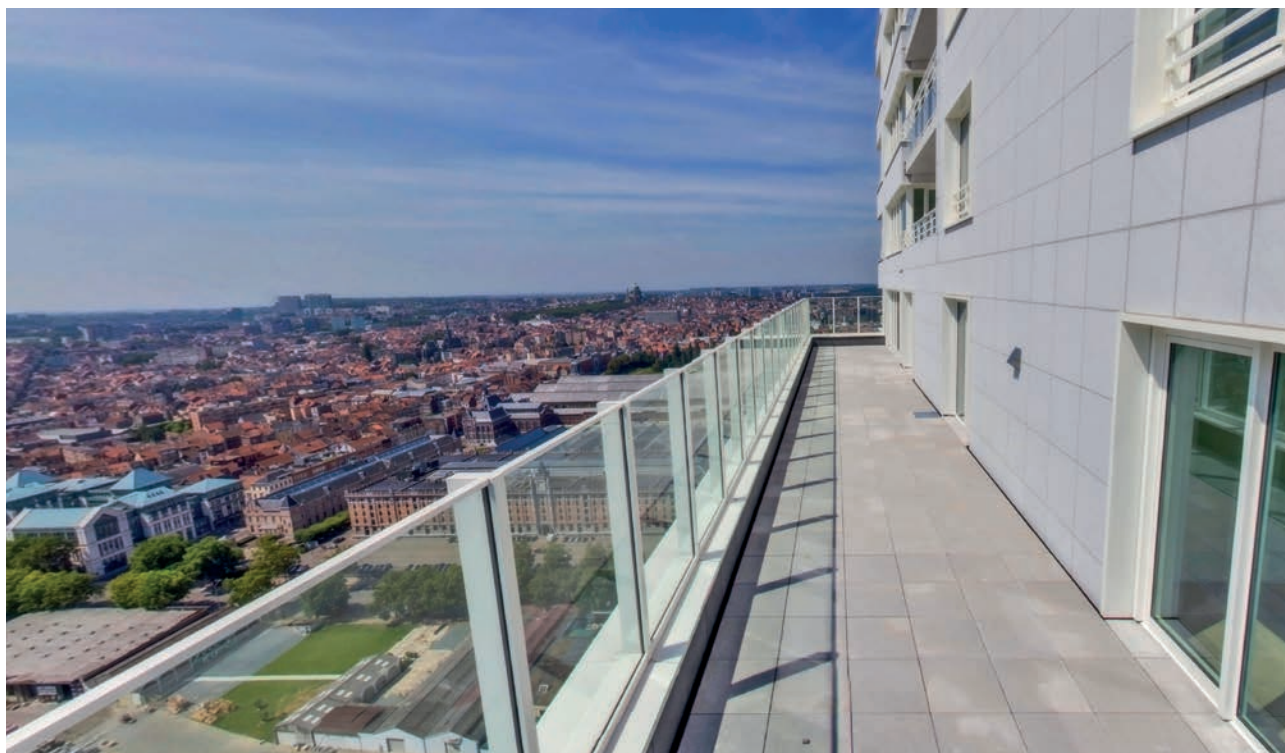
Up-site – Rooftop, terase i eksterijeri Bruxelles, Belgija
